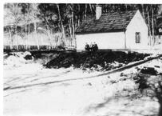
Einlaufplatzbau neben dem Gerätehaus des Tennisclubs 1956
