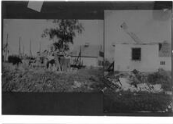
Abbruch des Gerätehauses des Tenniclubs im Jahre 1961 von den Eishockeyverein.
