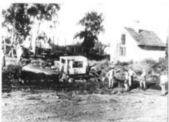
Baugerät im Einsatz beim Einlaufplatzbau links Dir. Gumbach 1956
