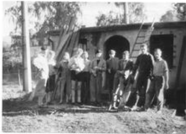
Arbeitsteam beim Abbruch des Gerätehauses vom Tennisclub 1961 v.links: Hr.Ing.Vedenhin Fr.Trampitsch Fr.Vedenhin Hr.Aunits Hr.Gerer Hr.Seebacher Hr.Perruzzi Hr.Feeberger Hr.Lepachy G.
